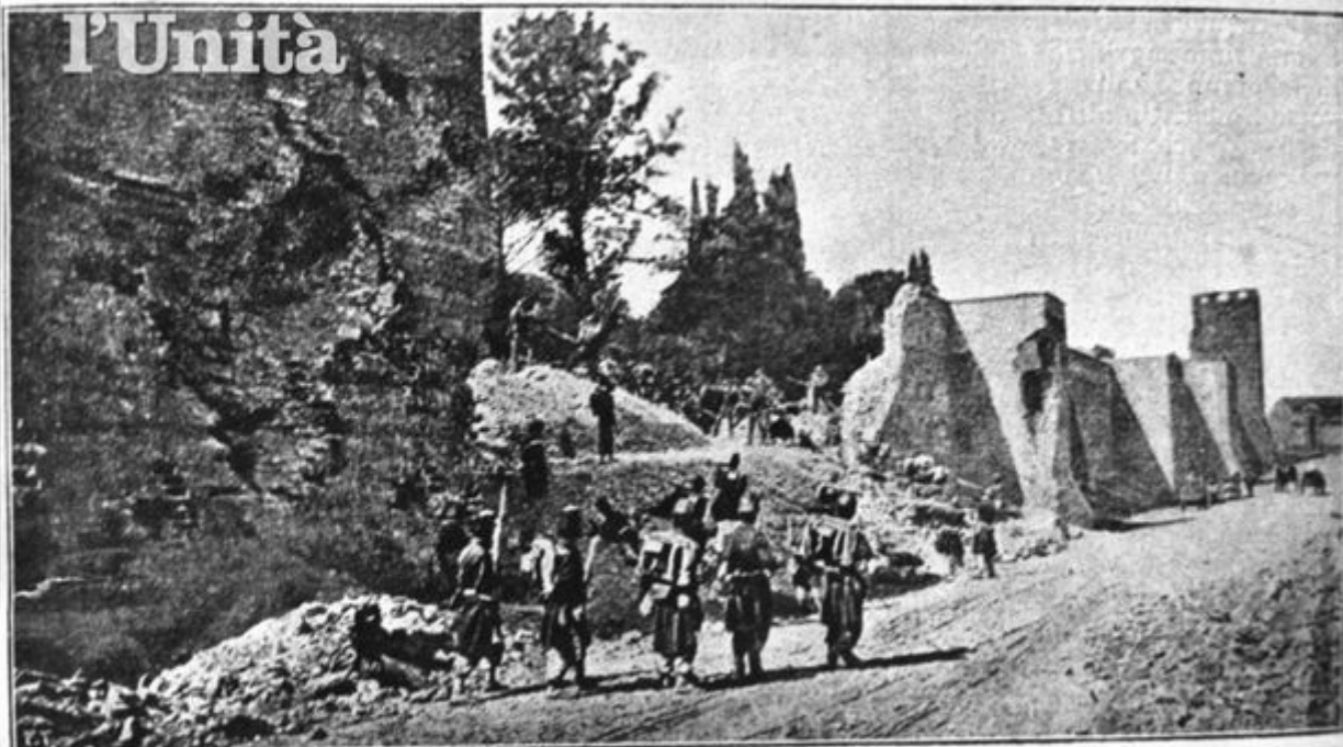
La breccia a sinistra di Porta Pia, poco prima dell'assalto (20 settembre 1870, ore 10 \frac{1}{2} ant.). (Fotografia del tempo.)
